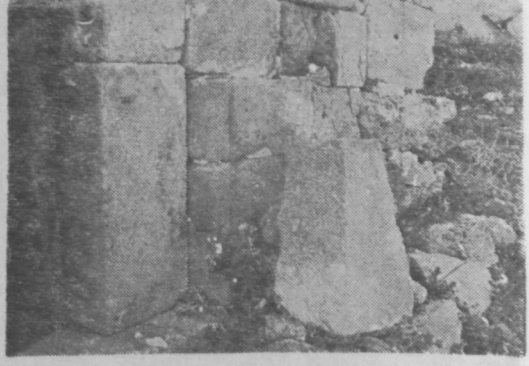
Foto 21 — Giriş kapısının sağ tarafı (Profilli kapı çerçevesi başlangıcı, söve ve kemer taşı)
