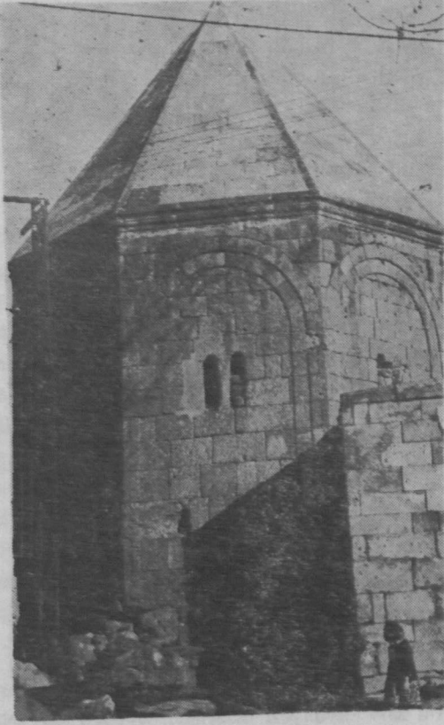
Foto 3 — Kayseri, Mesud Gülzar Türbesi
