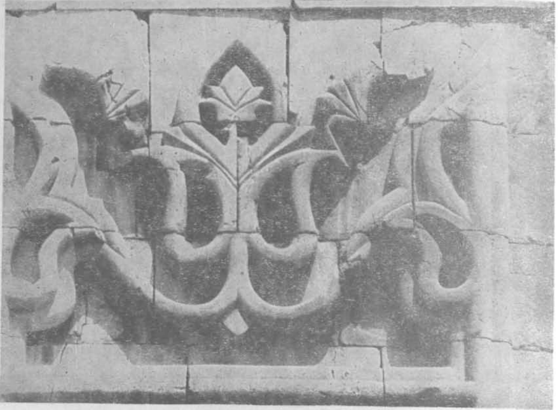
Resim. 20 Sivas Sahip Ata medresesi Taç kapı çıkıntısı Kuzey yüzü
