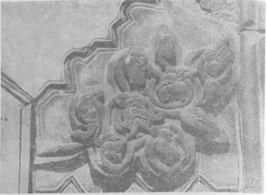
Resim. 19 Sivas Sahip Ata medresesi giriş kapısı Güney (Sağ) özengesi
