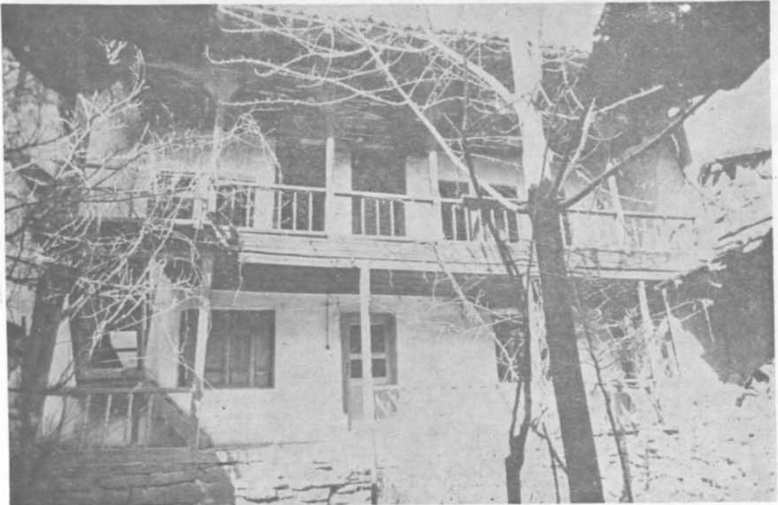
Resim 15 : Hayvaroğlu Sokağındaki evin cephesi
