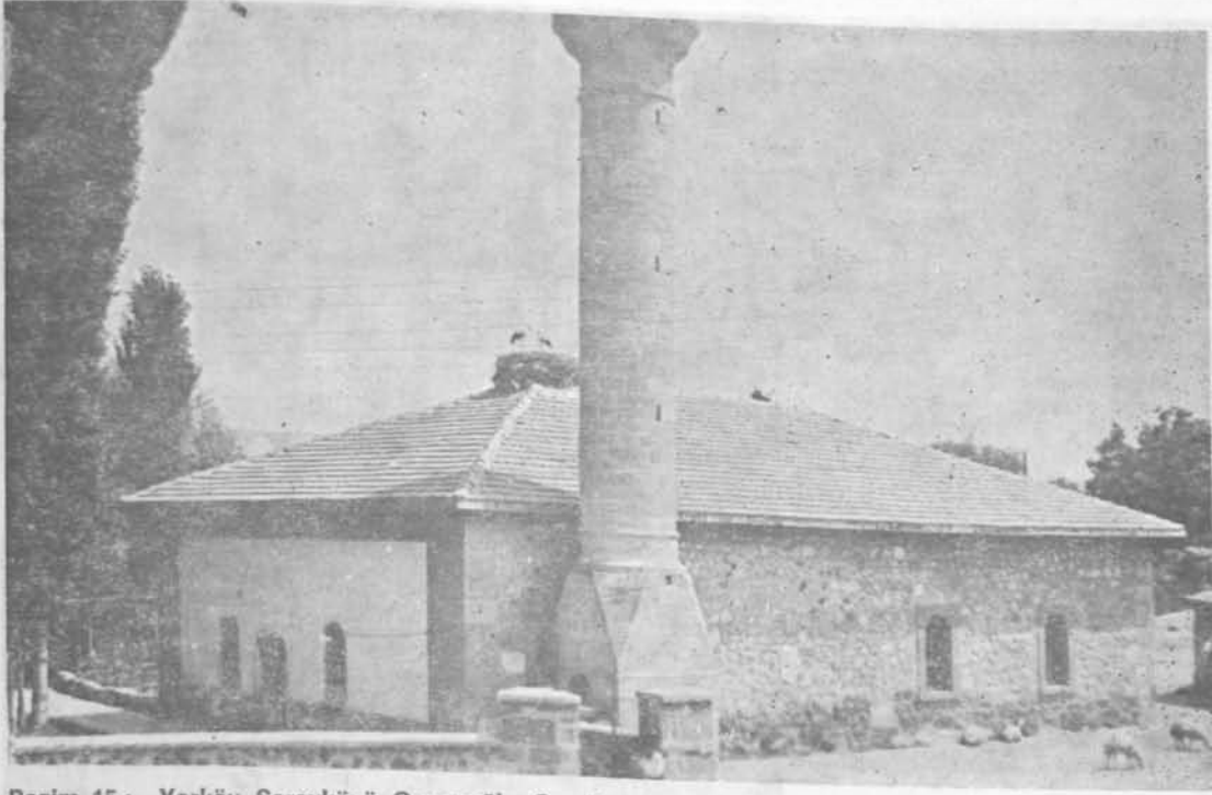
Resim 15 : Yerköy Sarayköyü Çapanoğlu Camii
