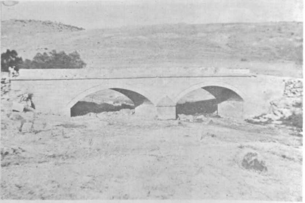
Resim 61 : Yozgat Şefaati yolu üzerinde bir köprü
