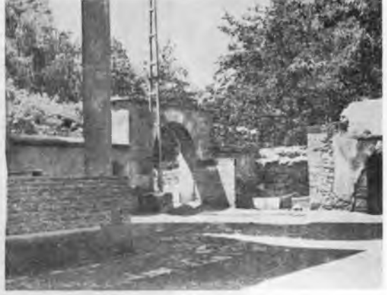
RESİM: 3 Camii avlu duvarı güney giriş kapısı
