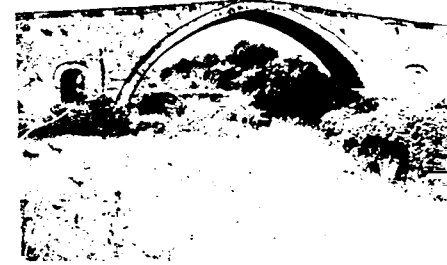
Albulku'da (Sinanlı) Mehmetpaşa Köprüsü
