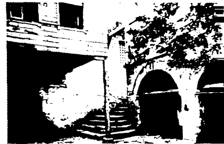
Sokullu Mehmet Paşa Tekkesi-kuzey-batı köşesindeki fevkanî ahşap mekân (Encümen 1935).
