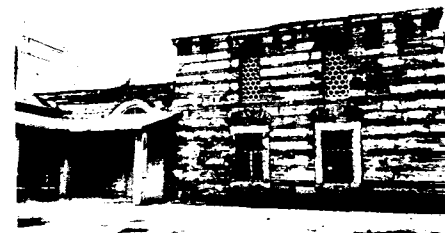
Sokullu Mehmet Paşa Tekkesi-tevhidhanenin doğu cephesi (Tanman).
