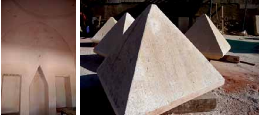
Fotoğraf 4- Medrese hücreindeki baca ve nişler ile medrese baca kapakları.
