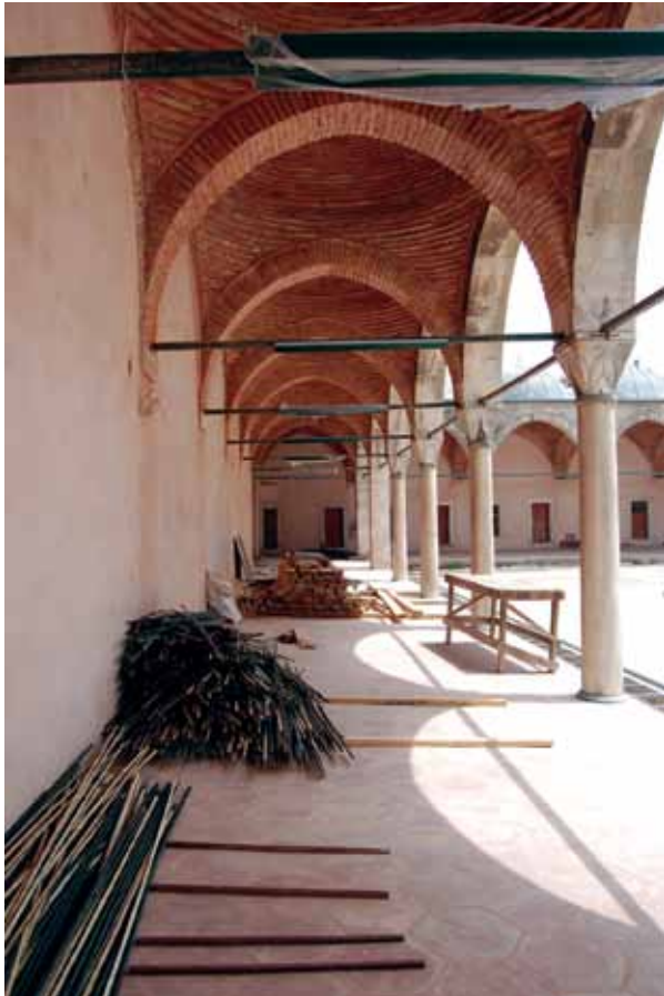
Fotoğraf 2 –Uygulama sırasında medrese revakları.
