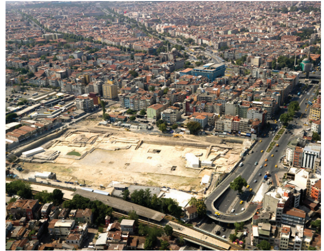
Fotoğraf 2: Yenikapı Marmaray-Metro Kazı Alanının Havadan Görünüşü
