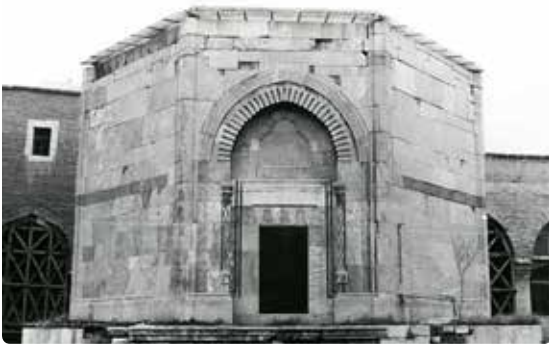
Resim 8- Anonim Türbe kuzey, kuzeydoğu kuzeybatı cepheler
