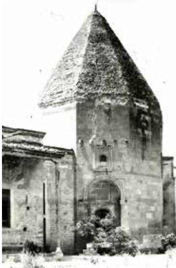
Resim 1- II. Kılıçarslan Türbesi kuzeydoğu cephe
