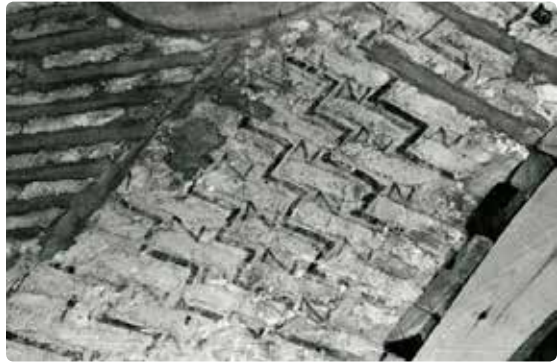
Resim 48- Alaeddin Camii ibadet mekânı mihrap önü kubbesi taşıyan kemerin kuzey yüzü
