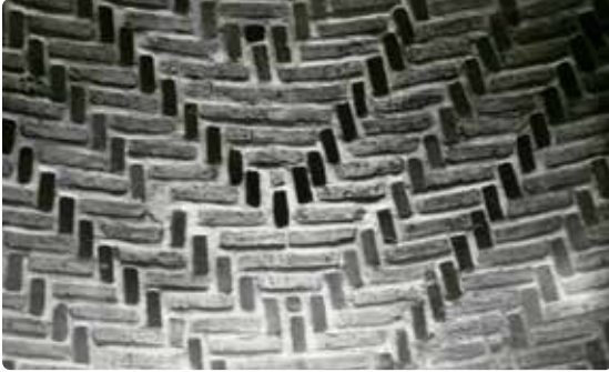
Resim 18- Sahip Ata Hanikâhı kubbe, ayrıntı cephe konsol ayrıntı
