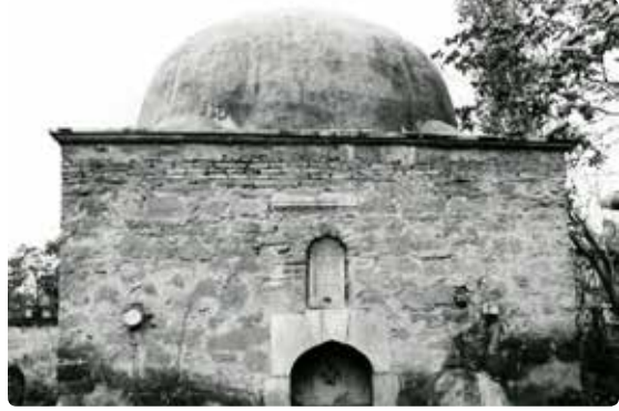
Resim 14- Şeyh Alaman Türbesi kuzey cephe
