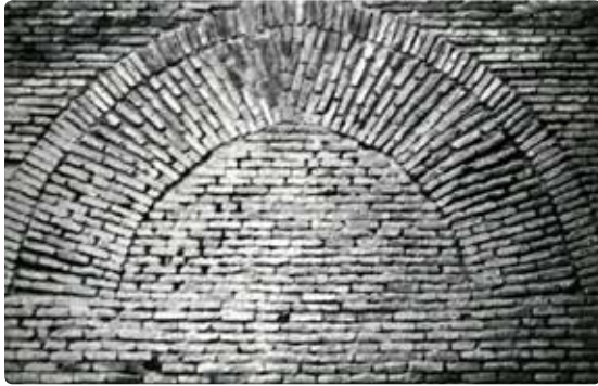
Resim 37- İplikçi Camii güney cephe, mihrabın ar- kasındaki kemer
