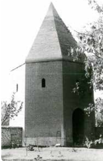
Resim 11-- Ulaş Baba Türbesi kuzeydoğu cephe
