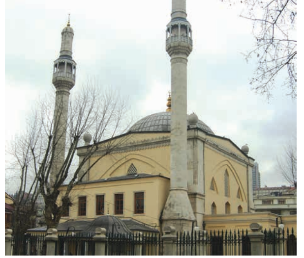
Fotoğraf.10- Kasımpaşa Güzelce Camii (Restorasyon sonrası günümüzdeki durumu), (Kaynak: VİBMA)
