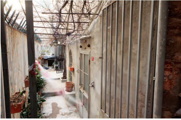
Fotoğraf 7. Batı cephe.
