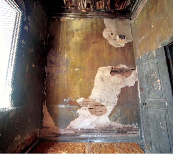
Fotoğraf 10. Bağdadi duvar ve yeni döşeme.
