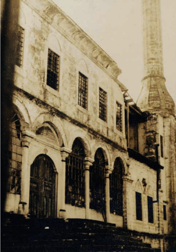
Fotoğraf 9. Minareyle bağlantı noktasında çöken çatının görünümü (İ.A.M.E.E.E.A.1964)
