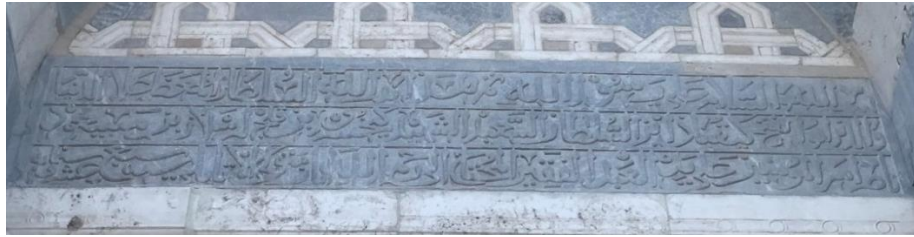
Fotoğraf 2.7 : Alaeddin Camii avlu duvarı sağır kemer altındaki kitabe(Esma Arıtan, 2019)
