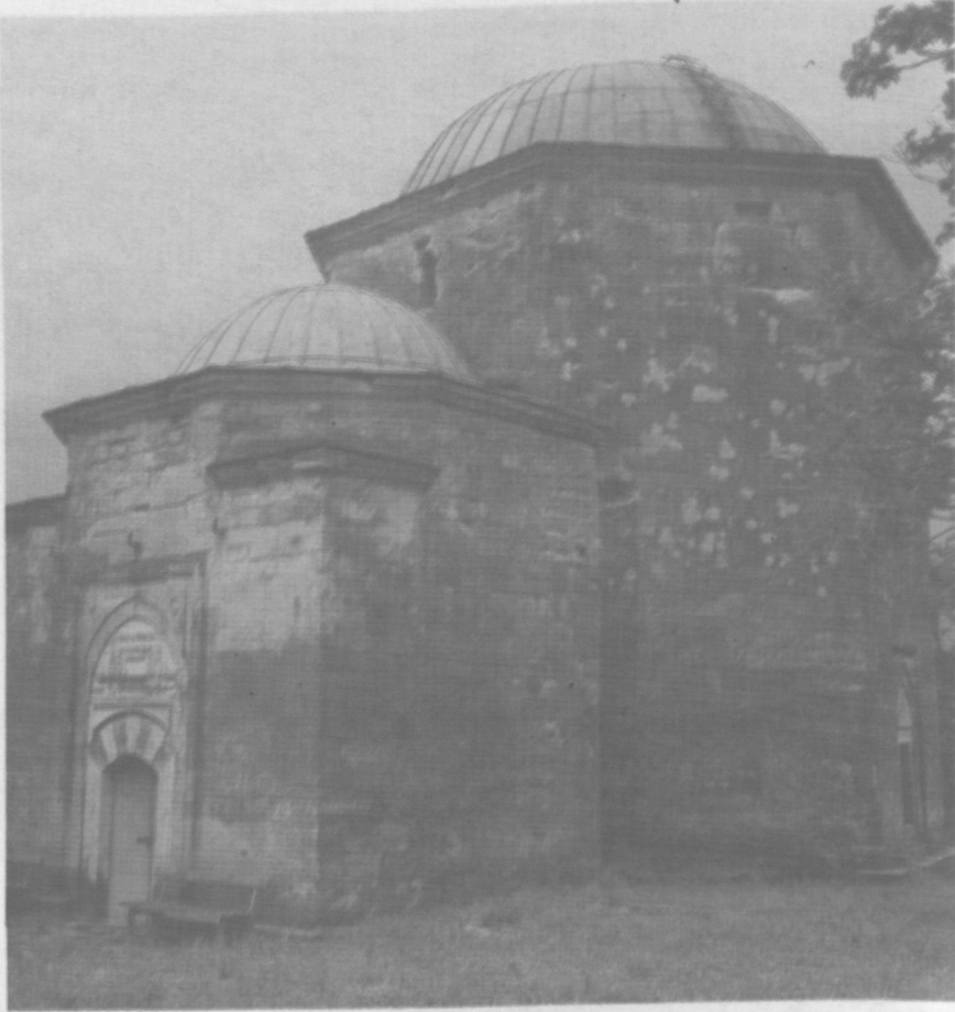
RESİM 5 Türbe ve giriş kısmının görünüşü.
