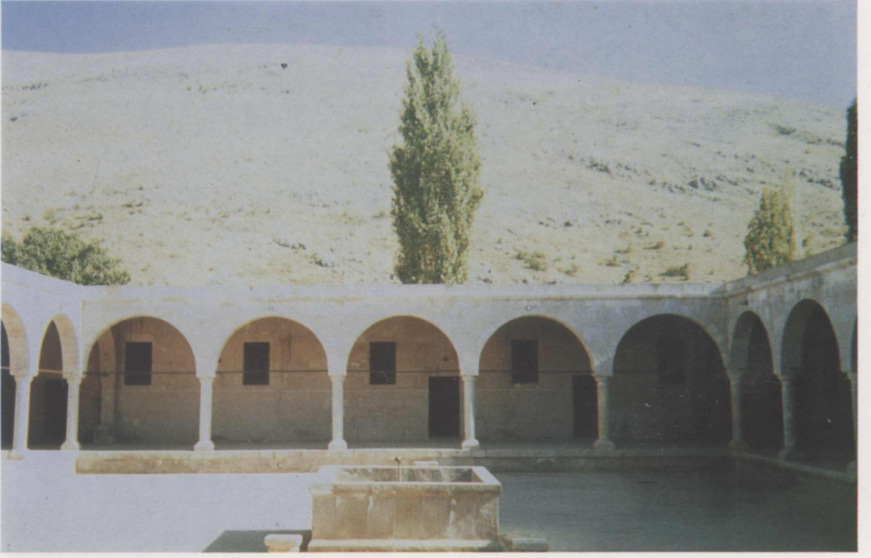
Resim 5: Şihli Hamidiye Medresesi avlu revaklarından (güney) görünüşü.
