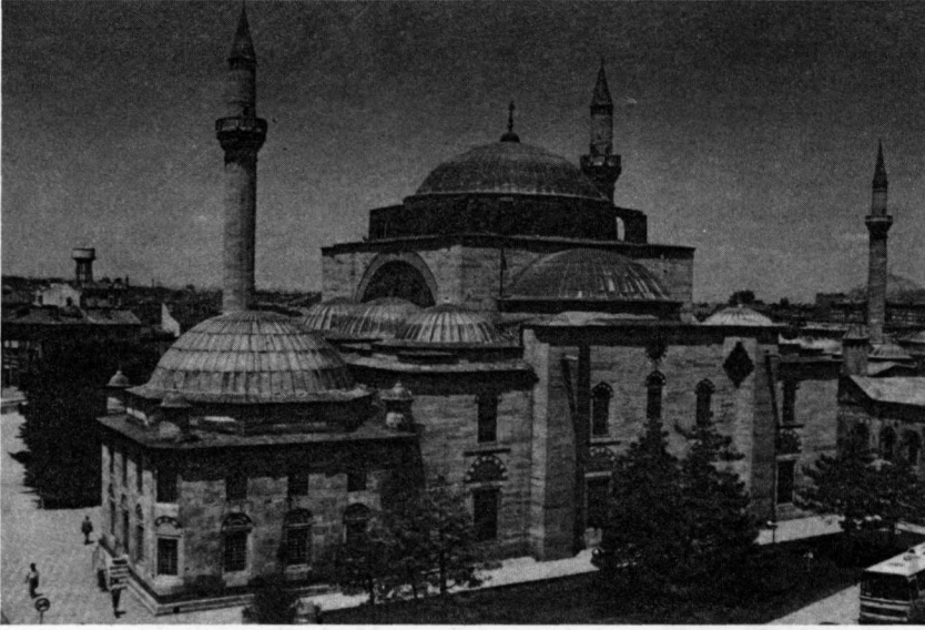
Resim 2: Konya Yusuf Ağa Kütüphanesi ve Selimiye Camii.
