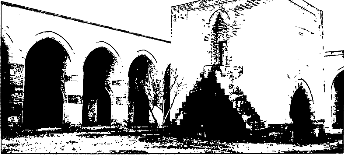
Resim 4: Aksaray-Sultan Hanı Fevkâni Mescid ve Altındaki Şadırvan
