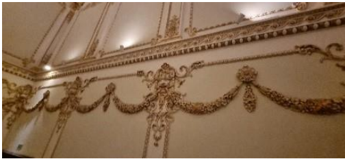
Resim 4. 32.: Giriş Kat Merdiven Duvarı
