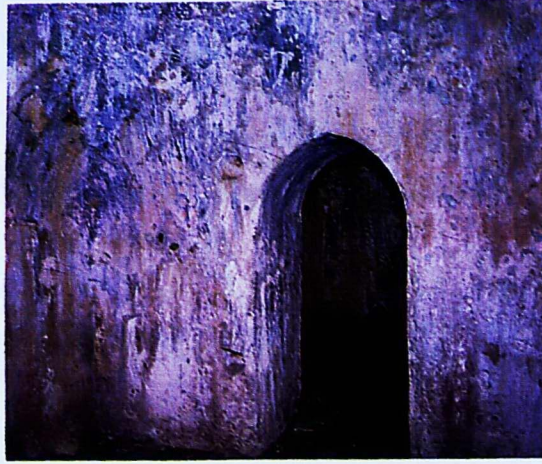
Lev. 14: Bozyazı Hamam, sıcaklık mekanı.
