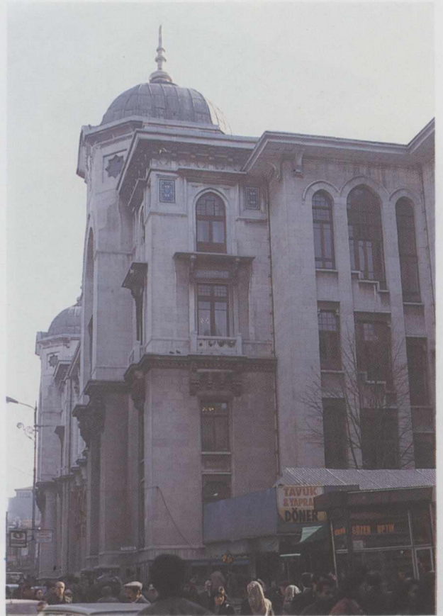
Res. 6: Mimar Vedat Bey tarafından inşa edilen Büyük Postahane
