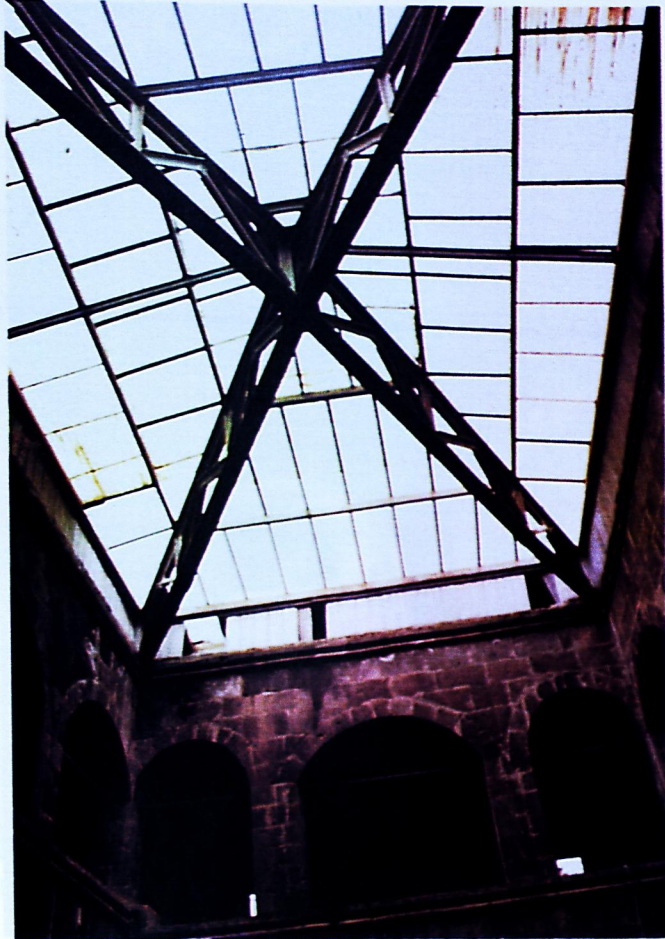
Fotoğraf 10: Hakkâri Meydan Medresesi Sonradan İnşa Edilmiş Örtü Görünüşü.
