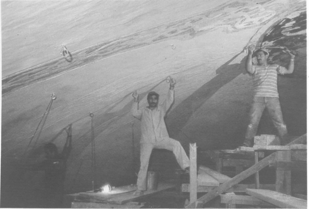
7- Sultan Ahmed Camii'nin kubbesinde düzeltilmiş rezonatör ağız (orjinal durumu bilinmiyor)
