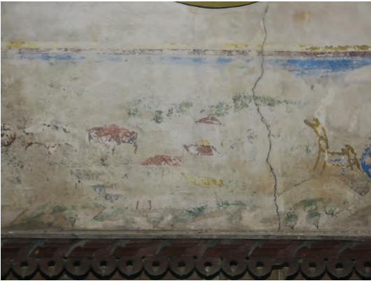
Resim 21- Restorasyon öncesi tren ve gar binası tasviri
