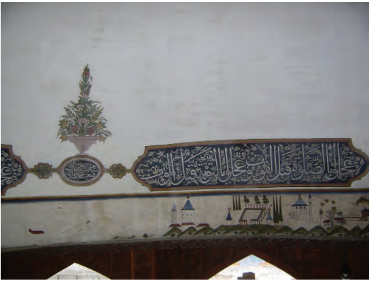
Resim 20- Restorasyon sonrası tanımlanamayan bölümler ve birkaç yapı tasviri
