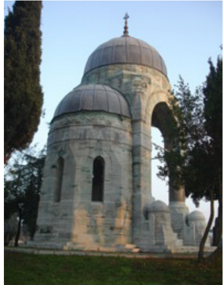
Fotoğraf 2: Mahmut Şevket Paşa Türbesi Kuzey Cephe
