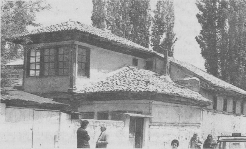
1. Binanın batı istikametinden genel görünüşü. Ön kısım avlunun kullanıl- masına ayrılmıştır. Resmin sağında görülen yüksek pencere- li uzun kısım sema icra olunan sabundur. Solda yüksek, pencere- li Cihannûma denilen kısım.
