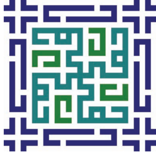
2.2. يا رحمن (ya Rahman). Şah-1 Zinde yapılarından Kadızâde-i Rumî türbesinin kuzey taraftaki alçak kubbe kasnağından detay
