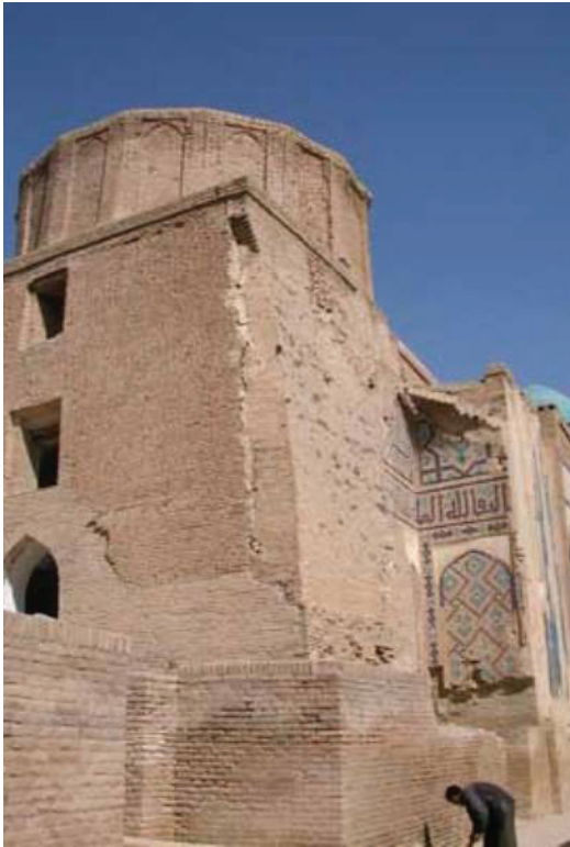
29. Emir Burunduk Türbesi güney cephesi
