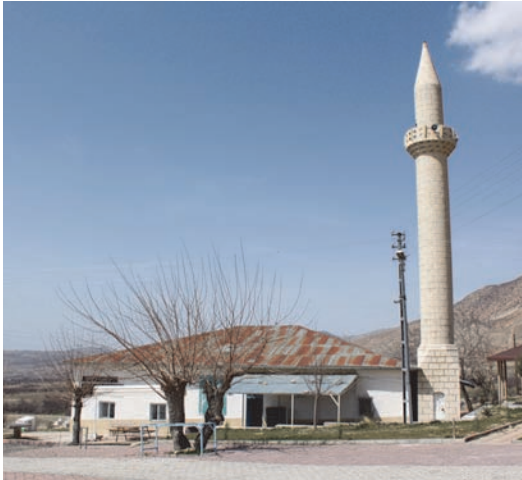
Ek-13: Hacı Hasan Baba Zâviyesi (Doğancık Köyü Camii)
