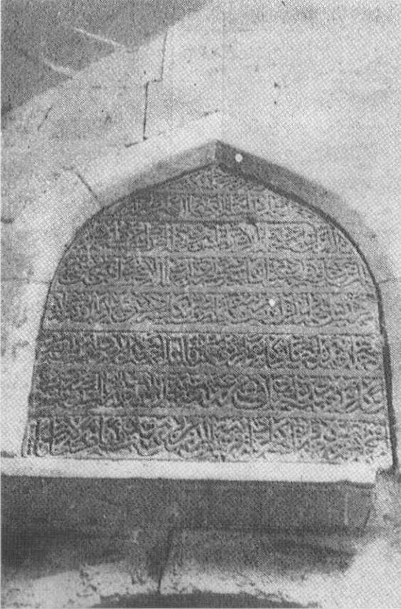
Res. 7: Karaman, Karamanoğlu İbrahim Bey'in taş vakfiyesi (Sağ köşe mekânı üzerinde).
