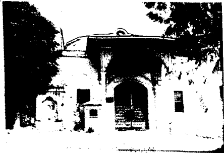
Üsküdar Atik Valide Kervansarayı
