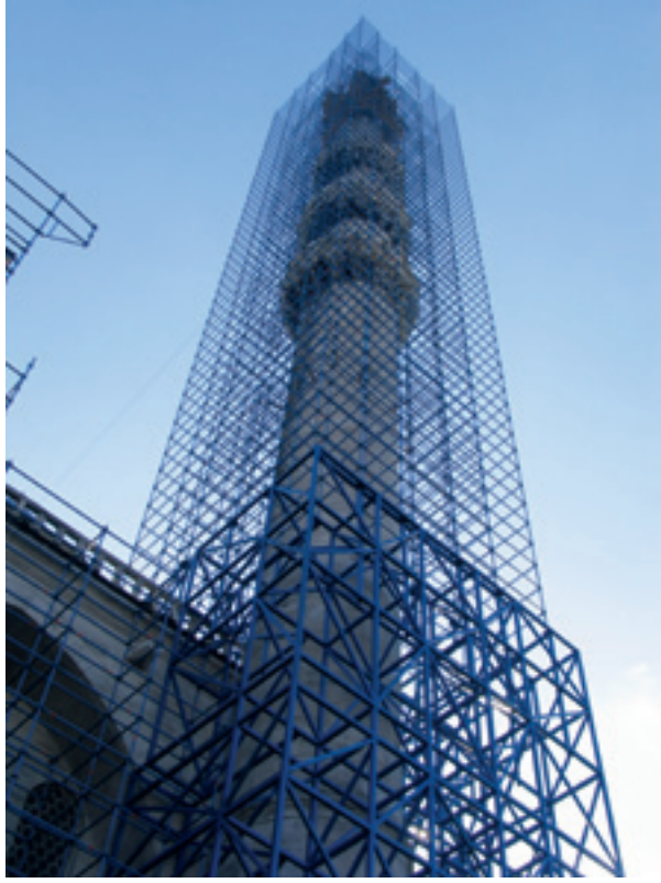
Fotoğraf 2 Dış cephe iskelesi
