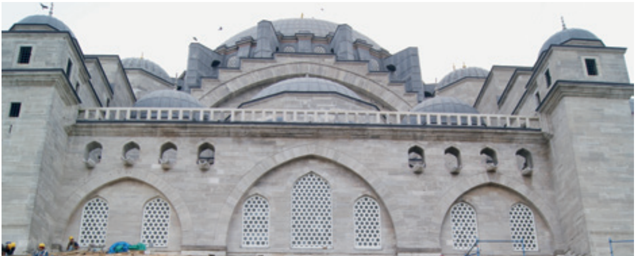
Fotoğraf 28 Cami korkuluk ve harpuşta değişim sonrası
