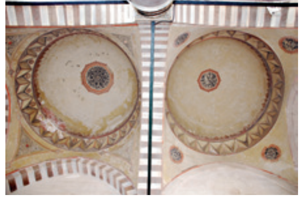
Fotoğraf 51 Avlu kubbeleri restorasyon öncesi
