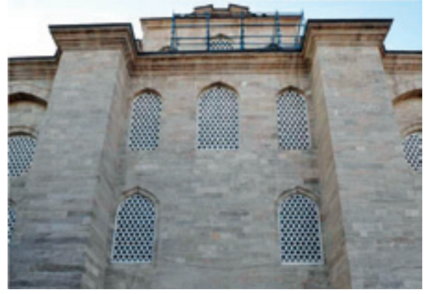
Fotoğraf 26 Cami Güney cephesi cephe restorasyon uygulamaları sonrası
