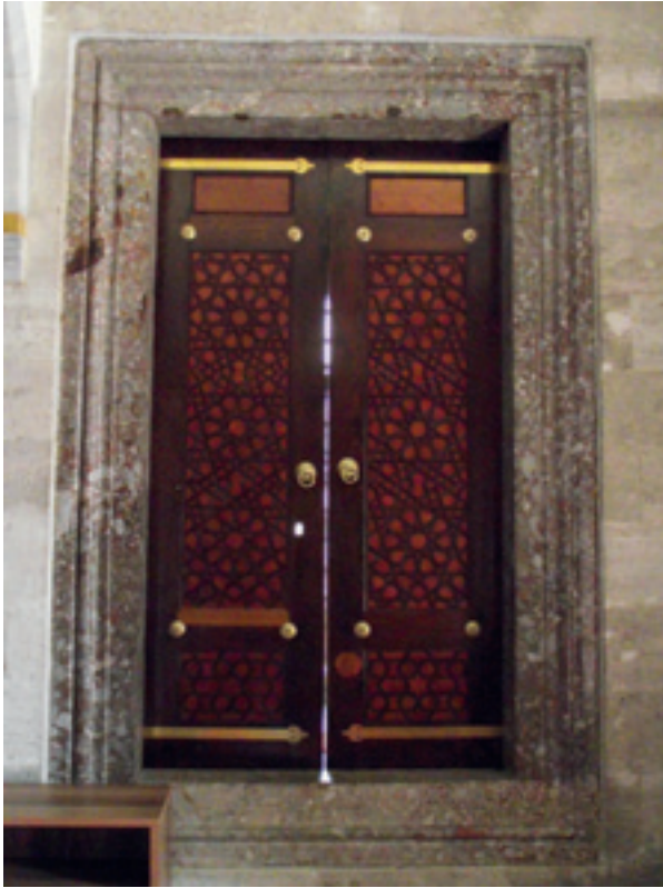
Fotoğraf 44 Ahşap kepenkler imalat sonrası
