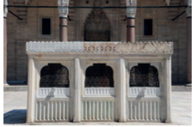
Fotoğraf 50 Su terazisi uygulaması sonrası
