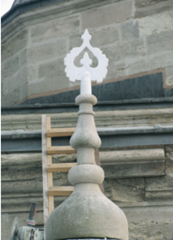
Fotoğraf 41 Kubbe alemlerinde tamamlama sonrası
