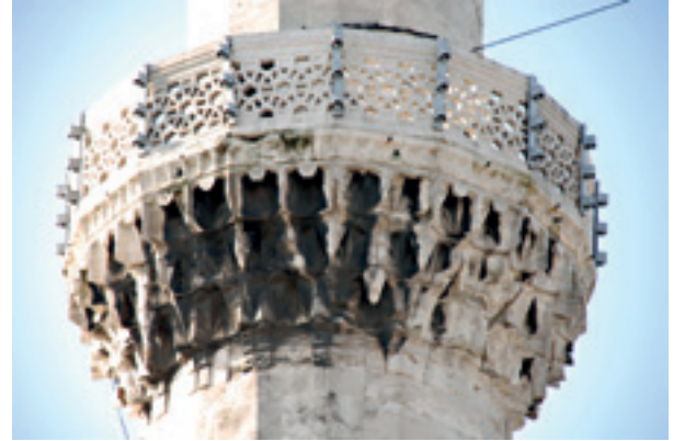
Fotoğraf 10 Minare şerefe altı mukarnaslarda parça kayıpları,
