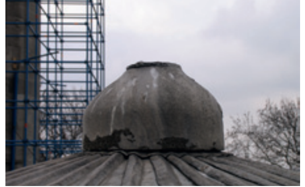
Fotoğraf 18 Parça kaybı olan kubbe alemleri
