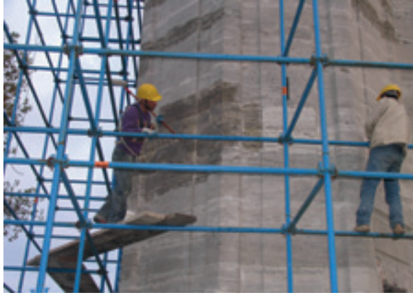
Fotoğraf 31 - Cephelerde yapılan yüzey sağlama ve su itici uygulaması
