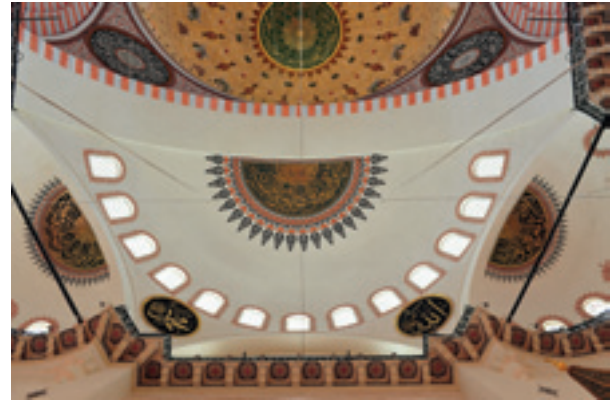
Fotoğraf 61 Yarım kubbe ve tromplar restorasyon sonrası
