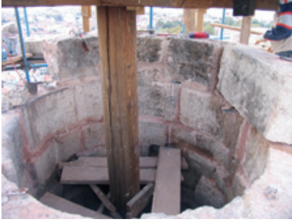
Fotoğraf 33 Minare petek kısmında yapılan sağlamlaştırma uygulaması
