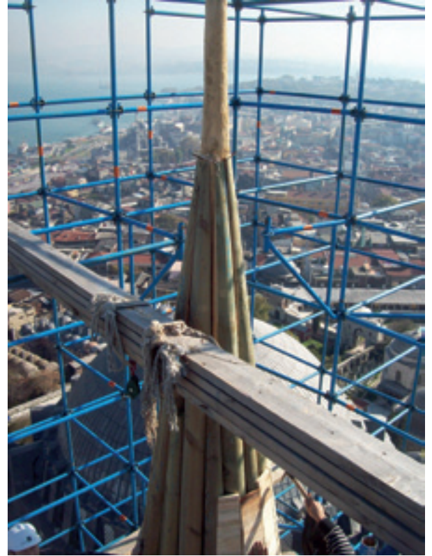
Fotoğraf 36 Minare külah değişim uygulaması
