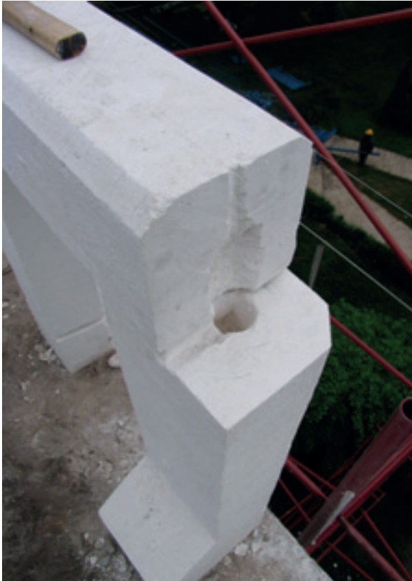
Fotoğraf 27 Cami korkuluk ve harpuşta değişim uygulaması
