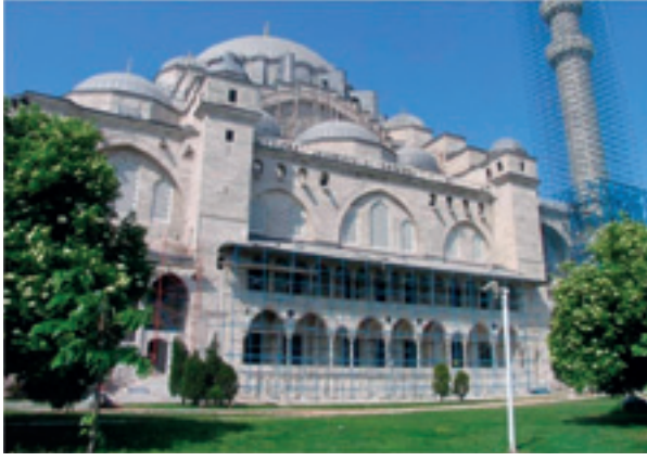
Fotoğraf 25 Cami doğu cephesi cephe restorasyon uygulamaları sonrası
