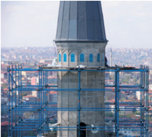
Fotoğraf 37 Minare çini montajı sonrası
