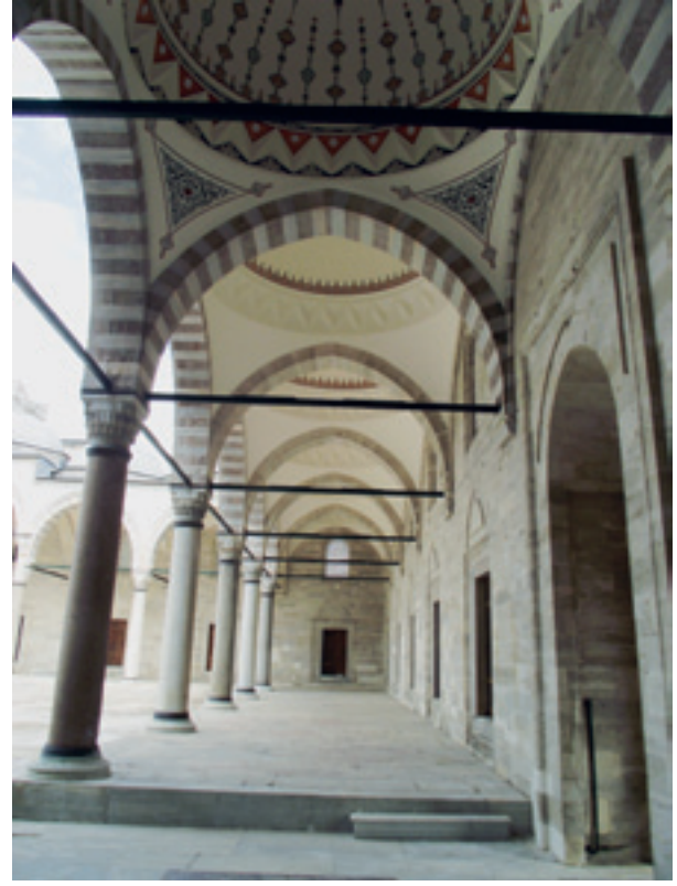
Fotoğraf 42/43 Horasan ve tezyinat sıvası tamamlanan yüzeyler
