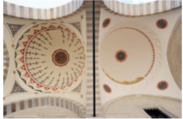
Fotoğraf 52 Avlu kubbeleri restorasyon sonrası
