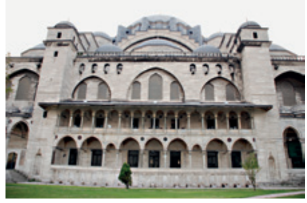
Fotoğraf 6 Cami doğu cephesi yoğun karbon birikimi,
