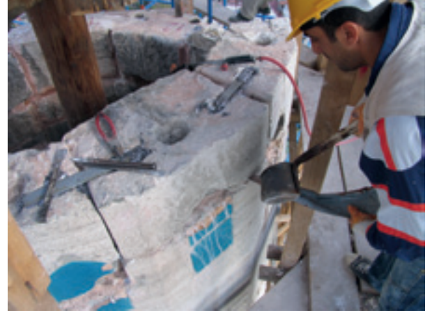
Fotoğraf 34 Minare petek kısmında yapılan sağlamlaştırma uygulaması
