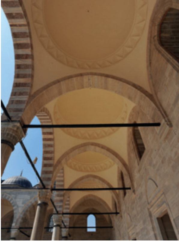
Fotoğraf 42/43 Horasan ve tezyinat sıvası tamamlanan yüzeyler
