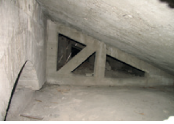
Fotoğraf 16 Betonarme saçak detayları,
