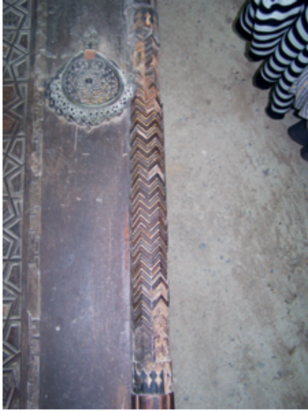
Fotoğraf 45/46 Kündekari kapılarda bulunan filatoların tamamlanması,
