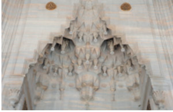
Fotoğraf 29 Mukarnas eksik parçalarının montajı sonrası
