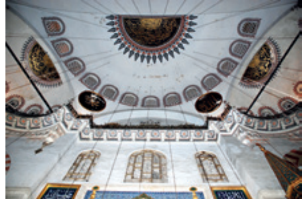
Fotoğraf 60 Yarım kubbe ve tromplar restorasyon öncesi
