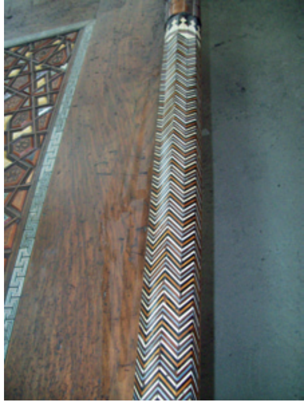
Fotoğraf 45/46 Kündekari kapılarda bulunan filatoların tamamlanması,
