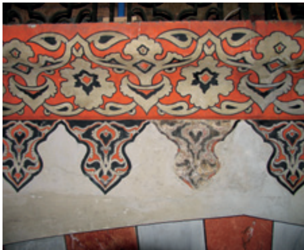
Fotoğraf 55 Ana kubbe kasnağı restorasyon öncesi
