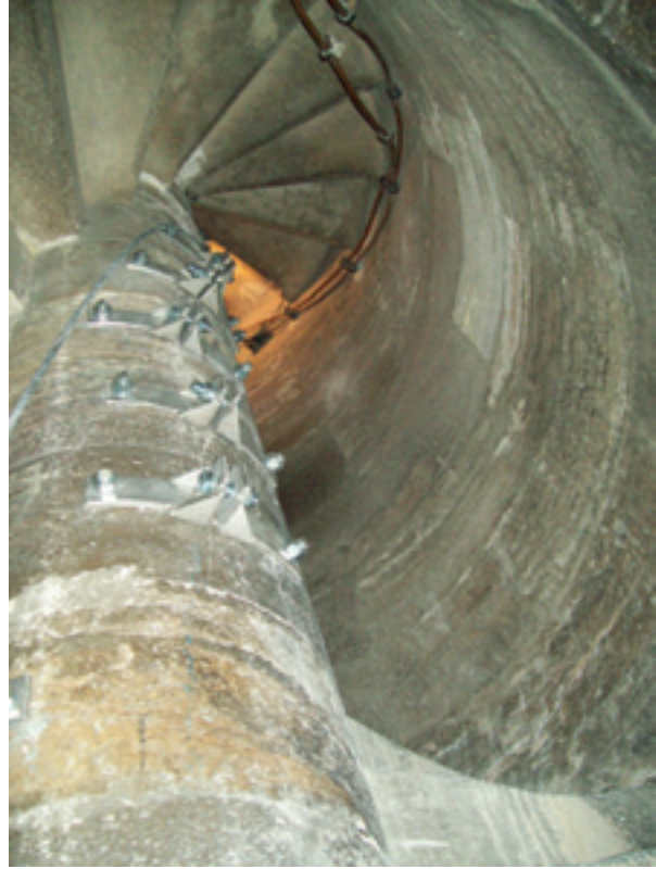
Fotoğraf 30 minare çekirdeğinde paslanmaz çelik ile yapılan uygulama
