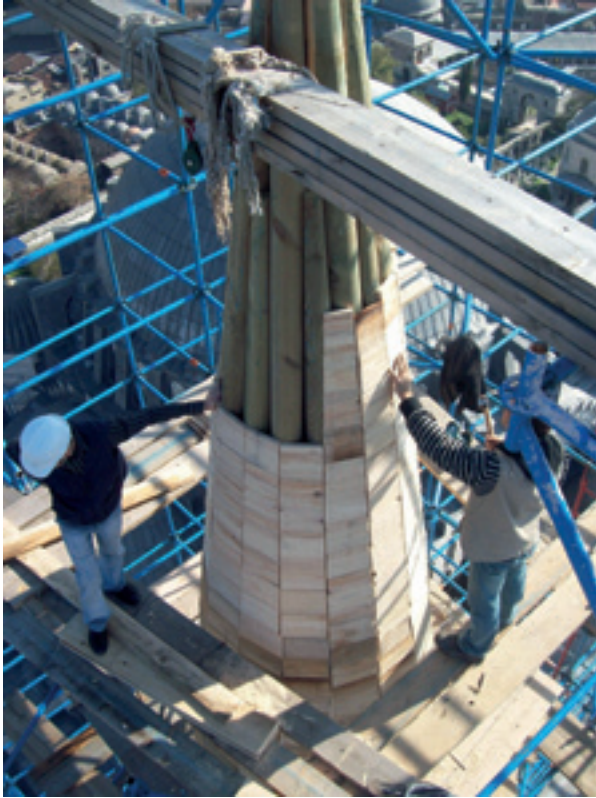
Fotoğraf 35 Minare külah değişim uygulaması
