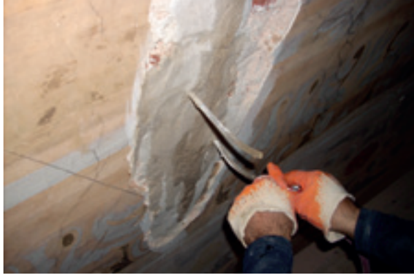
Fotoğraf 47 Ana kubbe içinden yapılan enjeksiyon ile sağlamlaştırma
