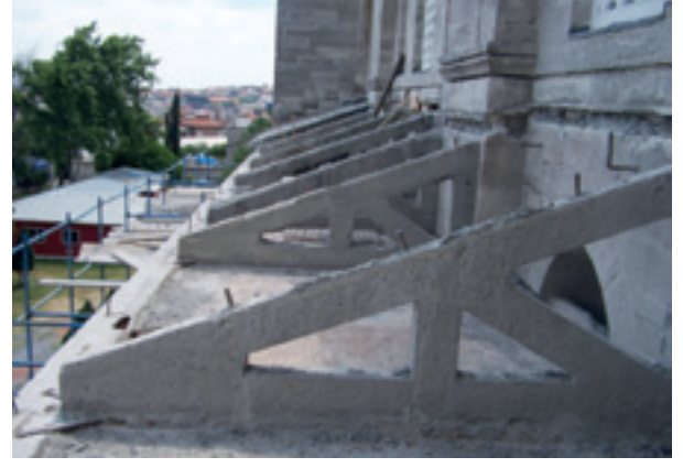
Fotoğraf 17 Betonarme saçak detayları
