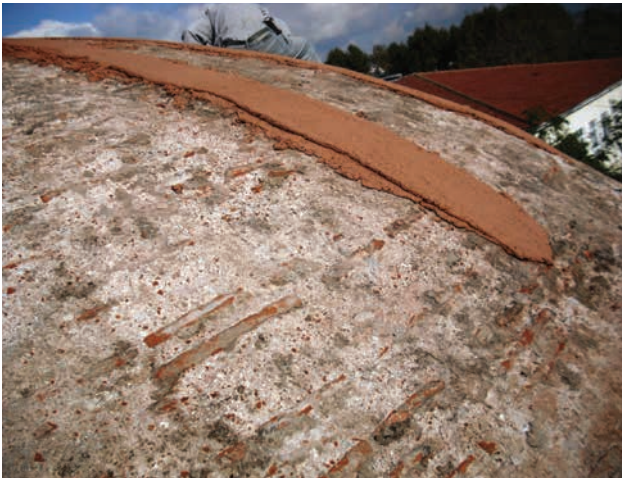
Resim 23. Kubbede horasan sıva yapımı.
