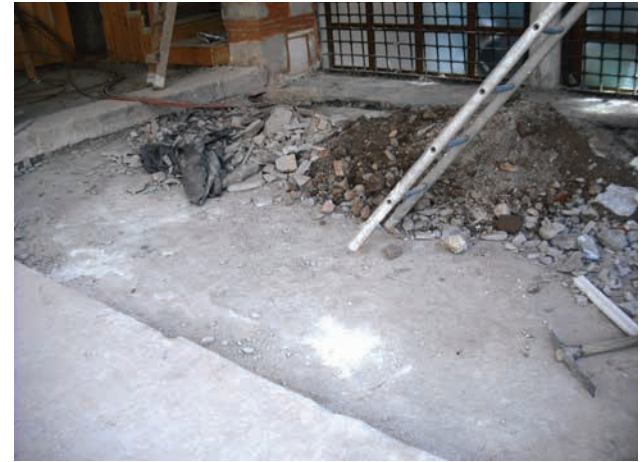
Resim 31. Son cemaat mahallindeki imitasyon tuğlaların sökülmesi.
