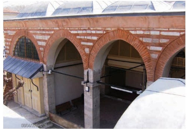
Resim 30. Restorasyon sonrasında son cemaat mahallinin avludan görünüşü.
