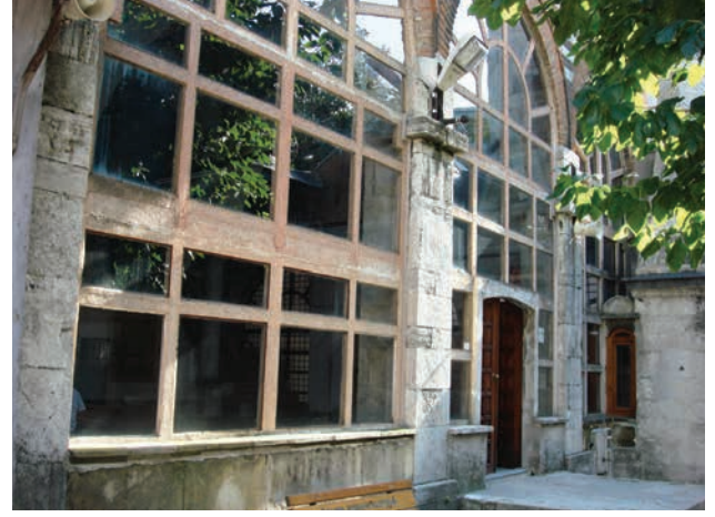
Resim 29. Restorasyon öncesinde son cemaat mahallinin avludan görünüşü.
