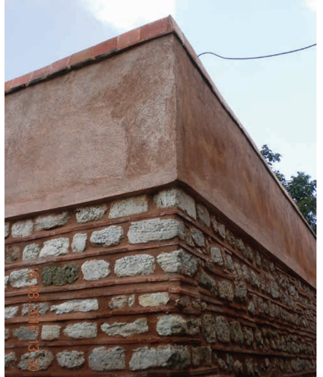
Resim 22. Kuzeybatı ve Güneybatı cephe duvarlarının görünüşü.
