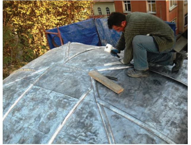
Resim 25. Tonozun üzerine kurşun kaplama yapılması.
