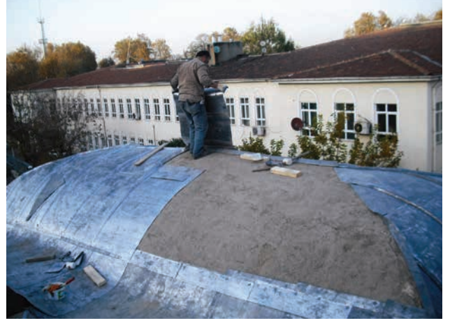
Resim 24. Tonoz üzerinde çamur sıva üzerine kurşun döşenmesi.
