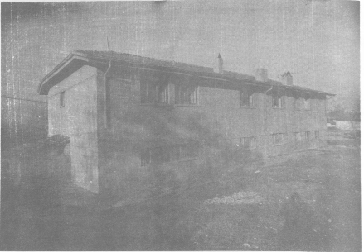
RESİM : 18- Etmesgut'da hamam olarak yapılan bina. Bugün memur lojmanı olarak kullanılmaktadır.
