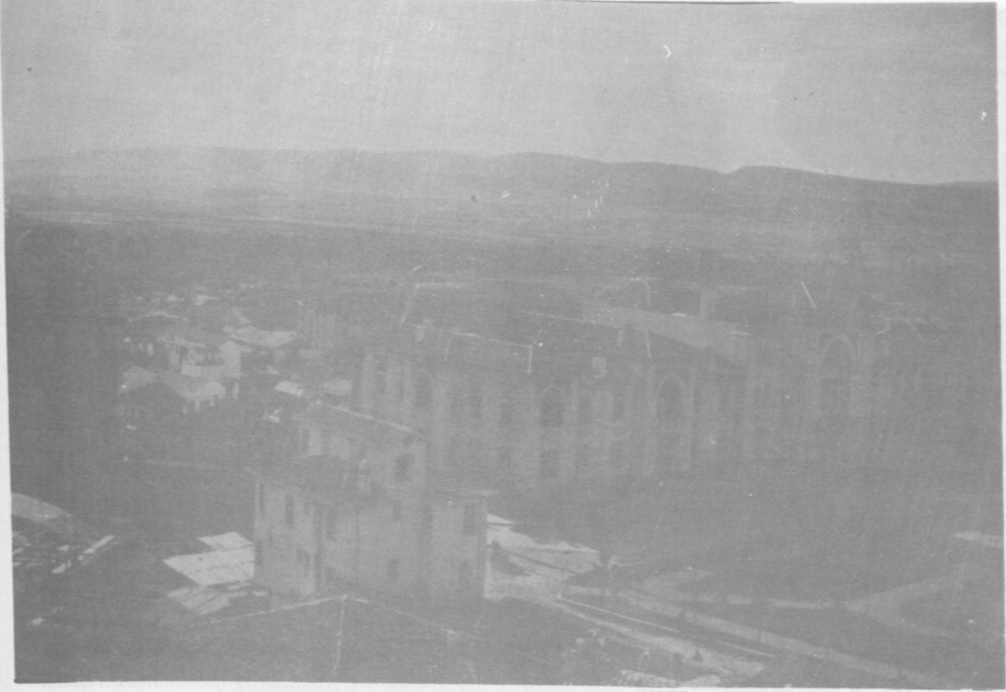
RESİM : 2- 1930 yılında Başbakanlık binası olarak kullanılan ve halen Maliye ve Gümrük Bakanlığı olarak kullanılan bina ve çevresi
