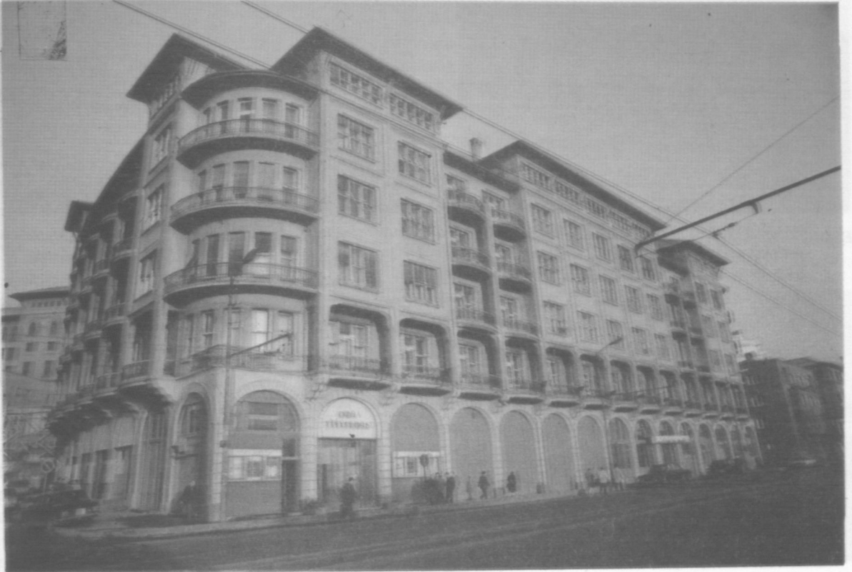
RESİM 25 : II. Vakıf Apartmanı.
