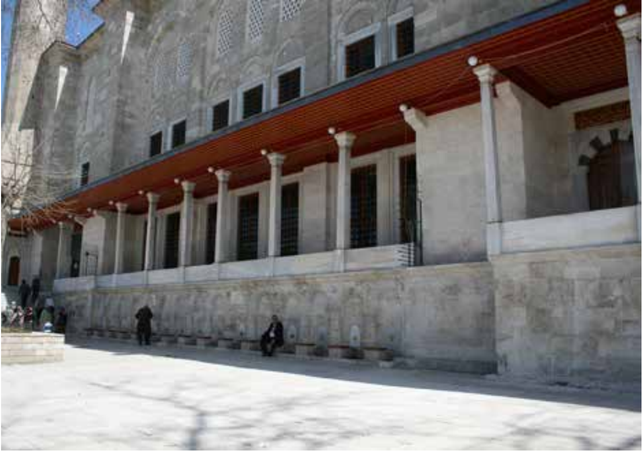
Fotoğraf 6 Restorasyon sonrası güneybatı cephesinde bulunan ahşap sundurma
