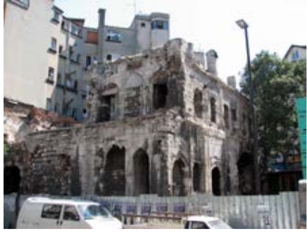
Fotoğraf 14. Hadım Hasan Paşa Medresesi Restorasyonu 2009 (TURES Digital Arşivi)
