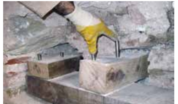
Fotoğraf 72. Takviyeli yeni ahşap hatlı sistemi
