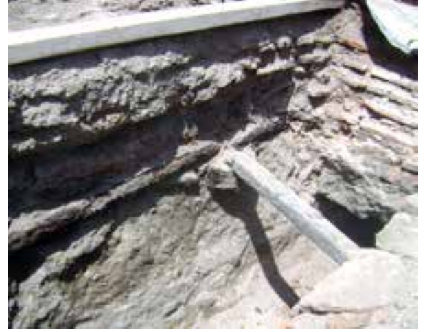
Fotoğraf 37. Dolaşmalık katı eski gergiler
