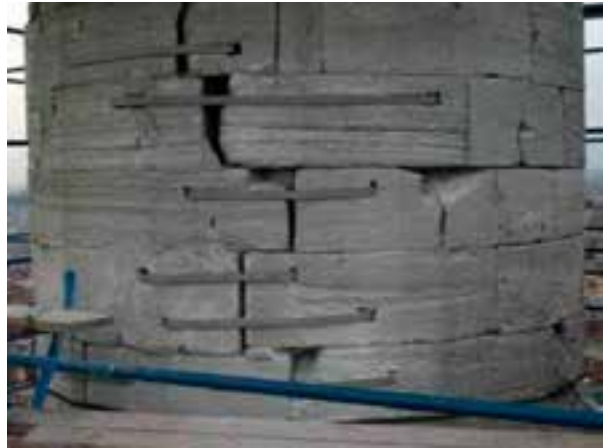
Fotoğraf 8. Paslanmaz çelik kenet uygulaması
