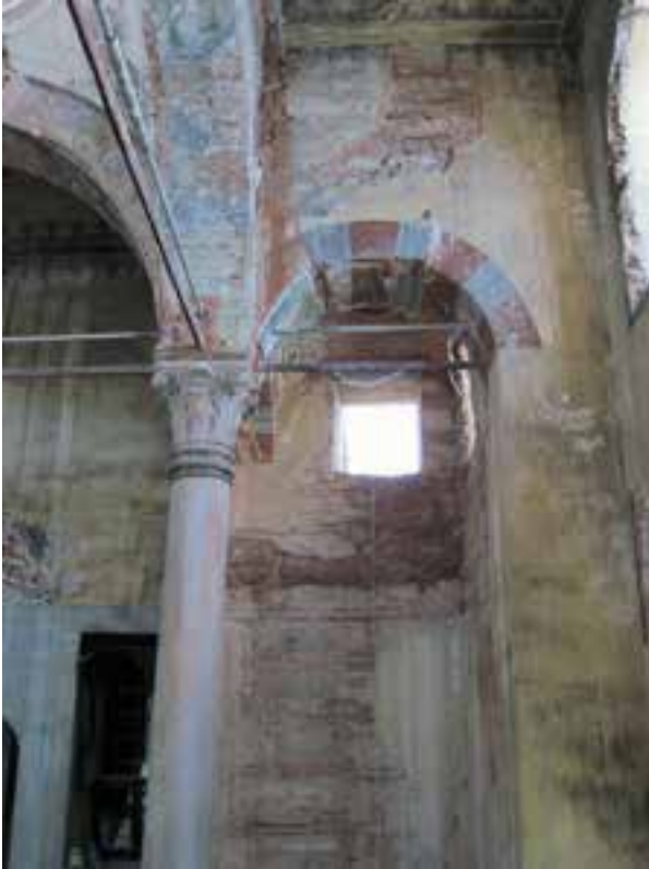
Fotoğraf 79. Paslanmaz çelik gergi sistemi (Askıya alma elemanları söküldükten sonra)
