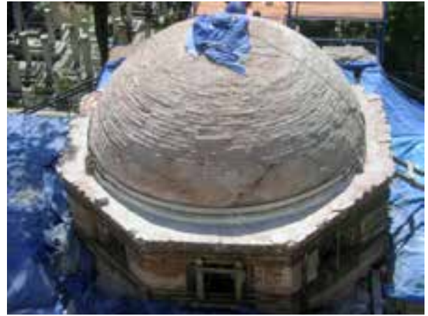
Fotoğraf 56. Paslanmaz çelik kuşaklama uygulaması
