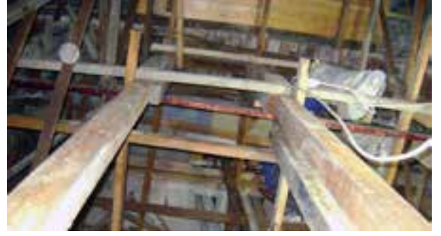
Fotoğraf 66. Kriko sistemiyle tonzun kaldırılması
