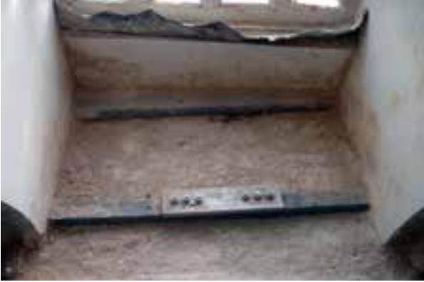
Fotoğraf 46. Hatıl sisteminde bulunlu birleşimlerle takviye yapılması
