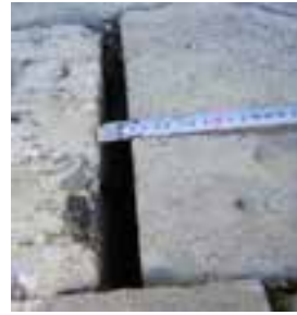
Fotoğraf 3-4. Minaredeki farklı genişliklerde ayrılmalar
