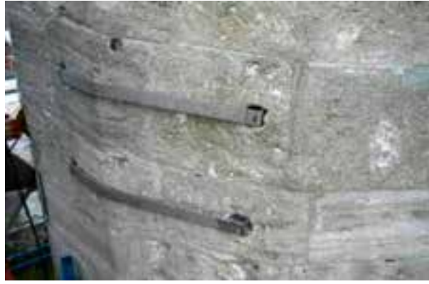
Fotoğraf 5-6. Paslanmaz çelik kenet uygulaması
