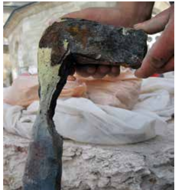
Fotoğraf 40. Dolaşmalık katı eski gergiler
