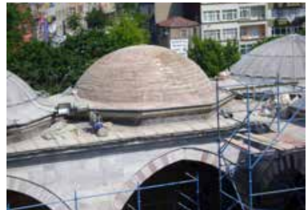
Fotoğraf 20. Kubbelerde çatlak onarımı
