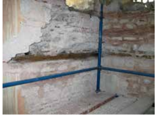
Fotoğraf 70. Özelliğini yitirmiş ahşap hatlı sistemi
