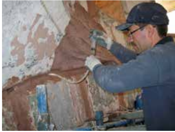
Fotoğraf 74. Kemer boşluklarına enjeksiyon yapılması işlemi
