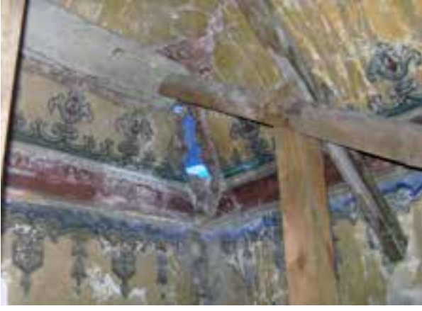
Fotoğraf 65. Tonzun yarıklarının içeriden görünümü
