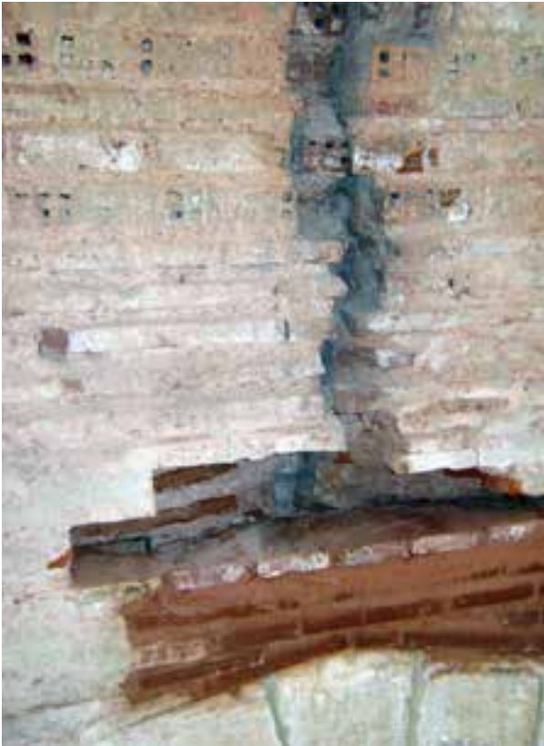
Fotoğraf 54. Kubbe çatlak onarımı
