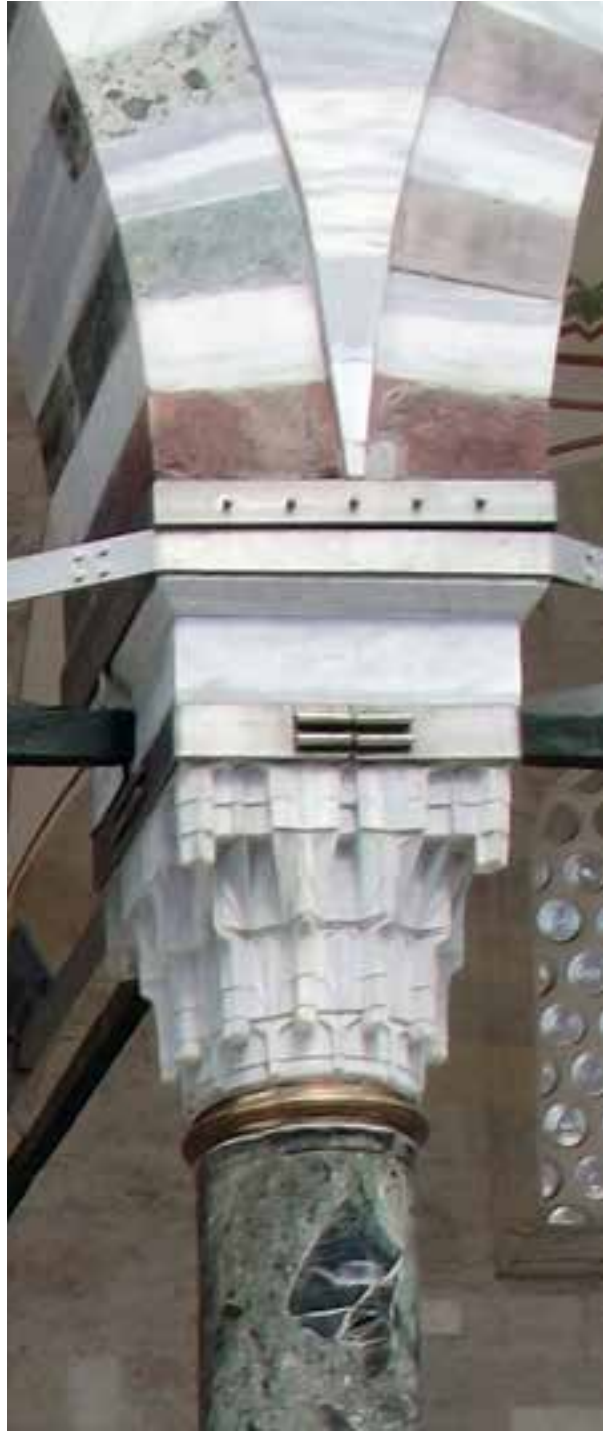
Fotoğraf 15. Paslanmaz çelikten sütun başlığı kuşaklama detayı
