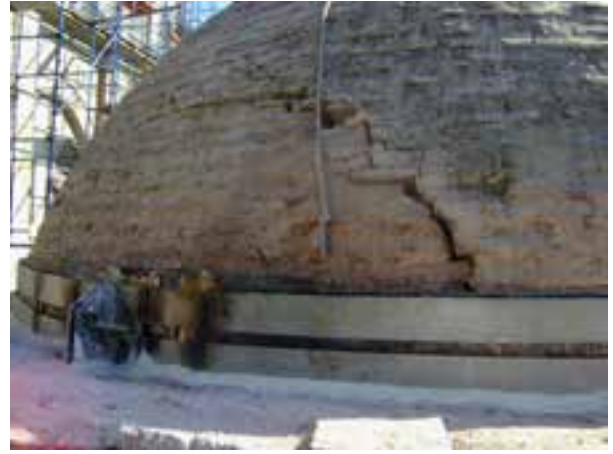
Fotoğraf 55. Paslanmaz çelik kuşaklama uygulaması
