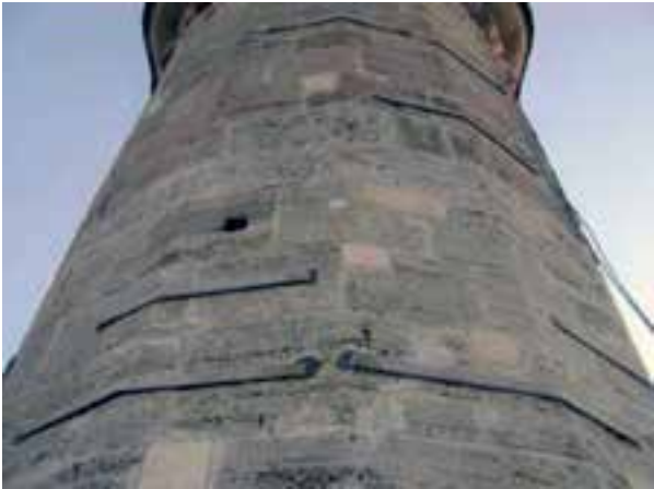
Fotoğraf 7. Paslanmaz çelik kenet uygulaması
