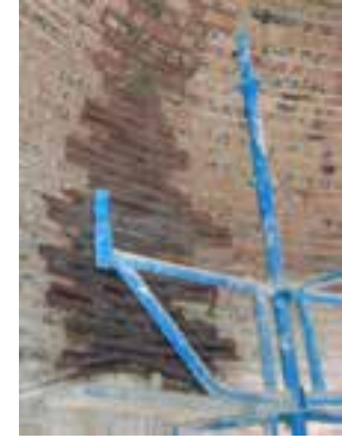
Fotoğraf 34-35. Çatlak hattı boyunca çürütme yöntemiyle kubbedeki çatlak onarımı
