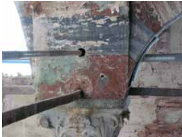
Fotoğraf 76. Paslanmaz çelik gergi uygulaması
