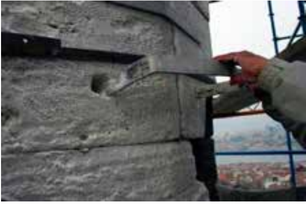
Fotoğraf 5-6. Paslanmaz çelik kenet uygulaması
