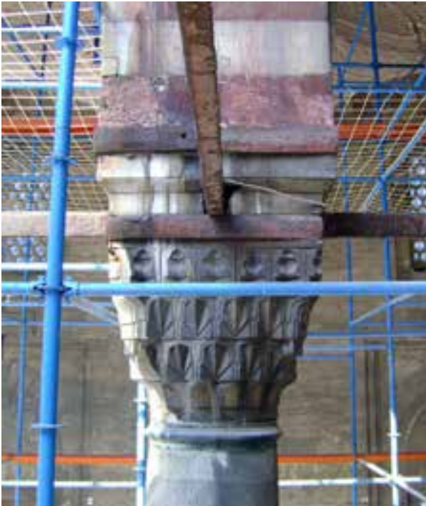
Fotoğraf 16. Revaklı avludaki eski gergi sistemi
