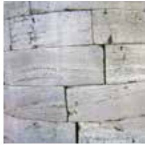
Fotoğraf 1-2. Minaredeki farklı genişliklerde ayrılmalar
