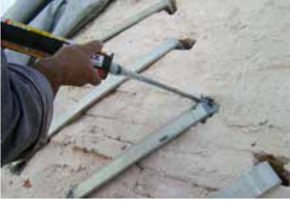
Fotoğraf 25. Paslanmaz çelik kenetlerle çatlak onarımı
