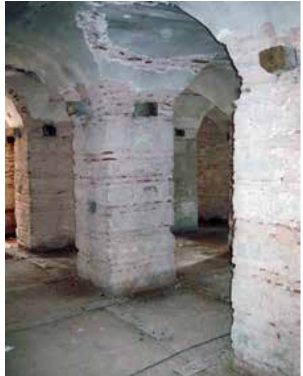
Fotoğraf 80. Bodrum kattaki özelliğini yitirmiş ahşap gergiler
