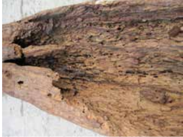
Fotoğraf 9. Dayanım özelliğini kaybetmiş ahşap hatıl
