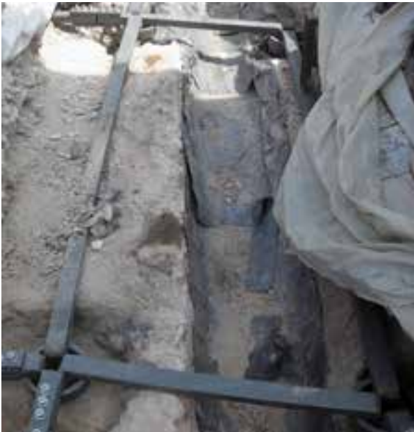
Fotoğraf 41. Dolaşmalık katı yeni gergi sistemi
