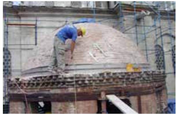
Fotoğraf 58. Paslanmaz çelik kuşaklama uygulaması
