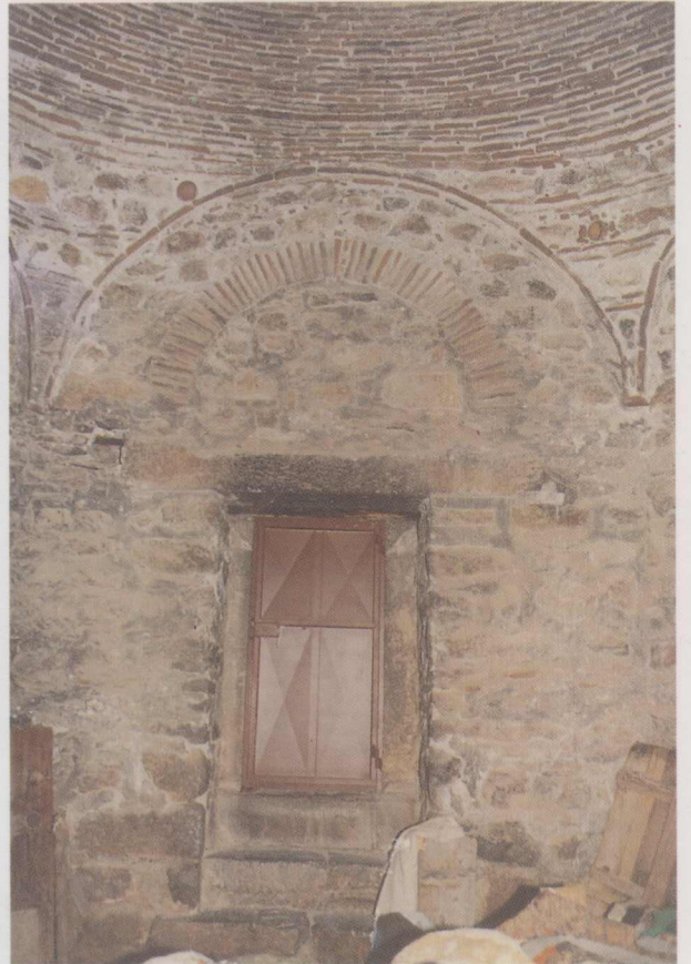
Res. 5: Aktürbe Tekkesi'nin kubbeye geçiş elemanları
