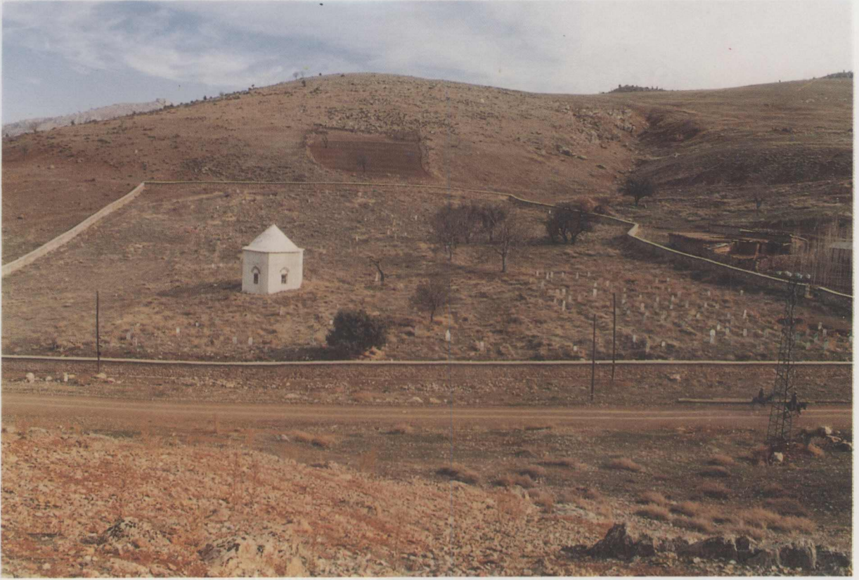
Res. 1: Aktürbe Tekkesi'nin içinde bulunduğu mezarlıktan genel görünüş
