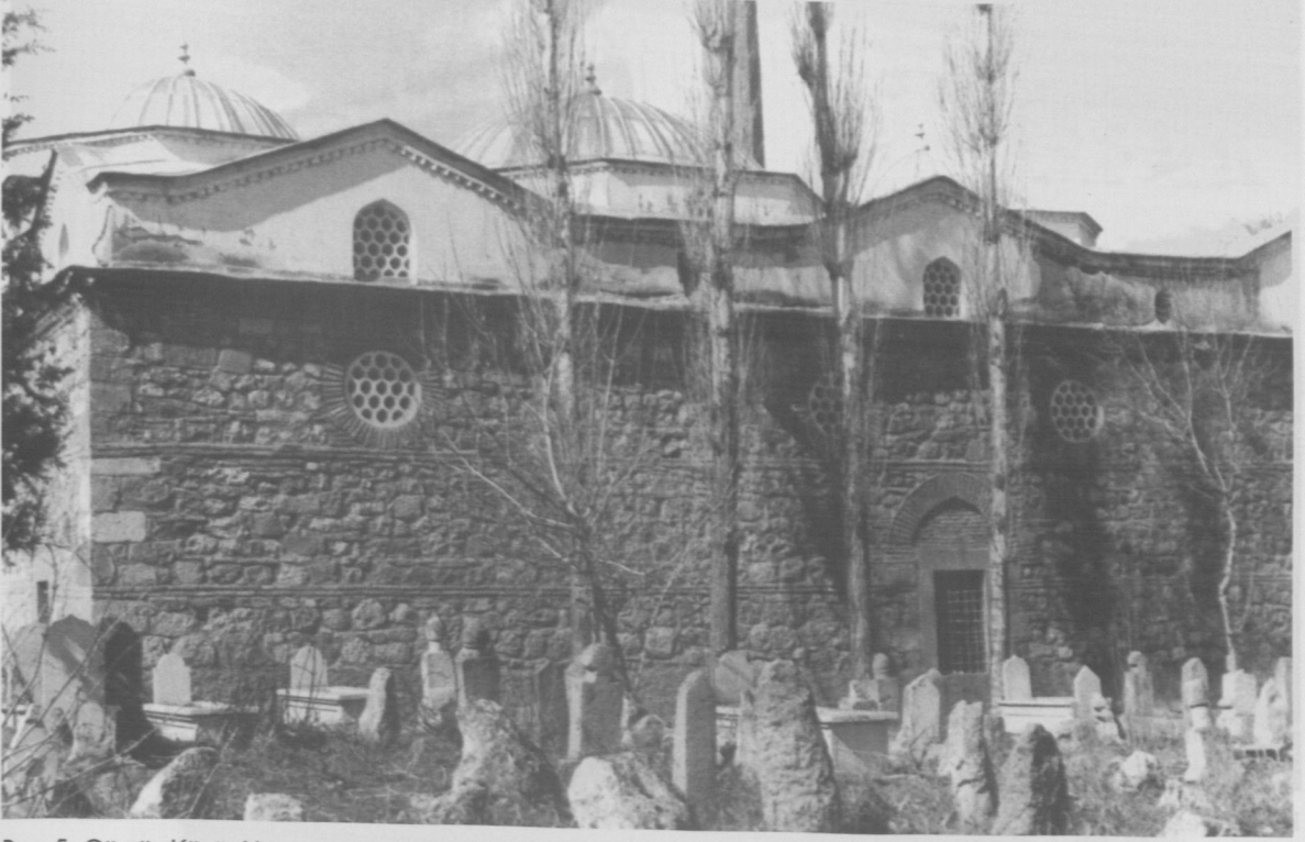
Res. 5: Gümüş Köyü, Yörgüç Paşa Camii, Batı Cephe.
