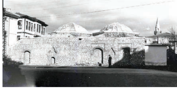
Fotoğraf 12 Tabaklar Hamamı'nın 1965 onarımı sonrası güney cephe (VGM arşivi)
