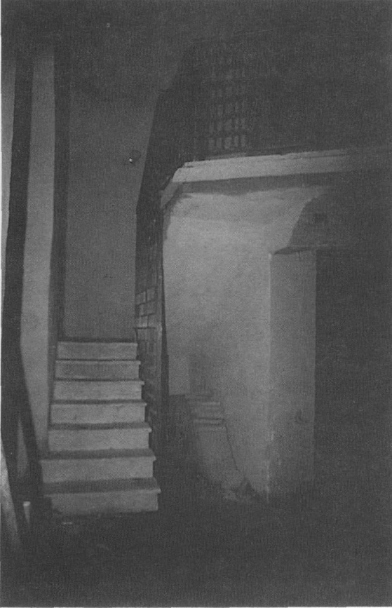
5. Bedesten içerisinde yapılan merdiven.
