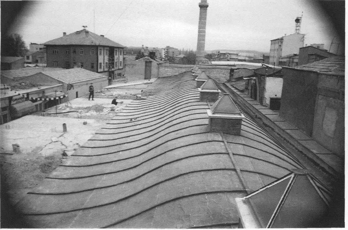
4. Üst örtünün onarım sonrasında görünüşü.
