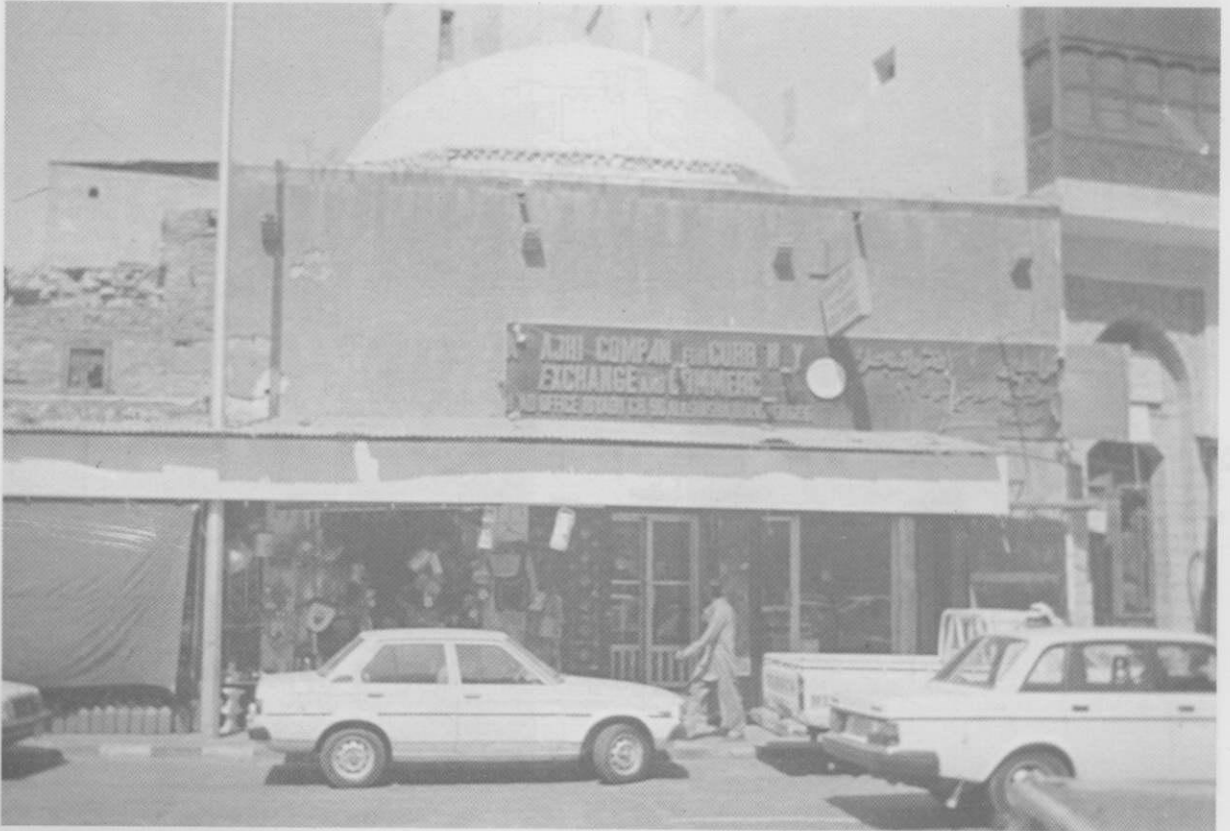
Res10: Gıřaşıye mahallesindeki Sultan Süleyman Han Hamamı.
