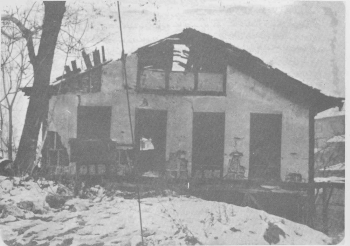
Resim 2. Bursa-Osmangazi ilçesi Dullarevi (Darülaceze) güney cephesi.
