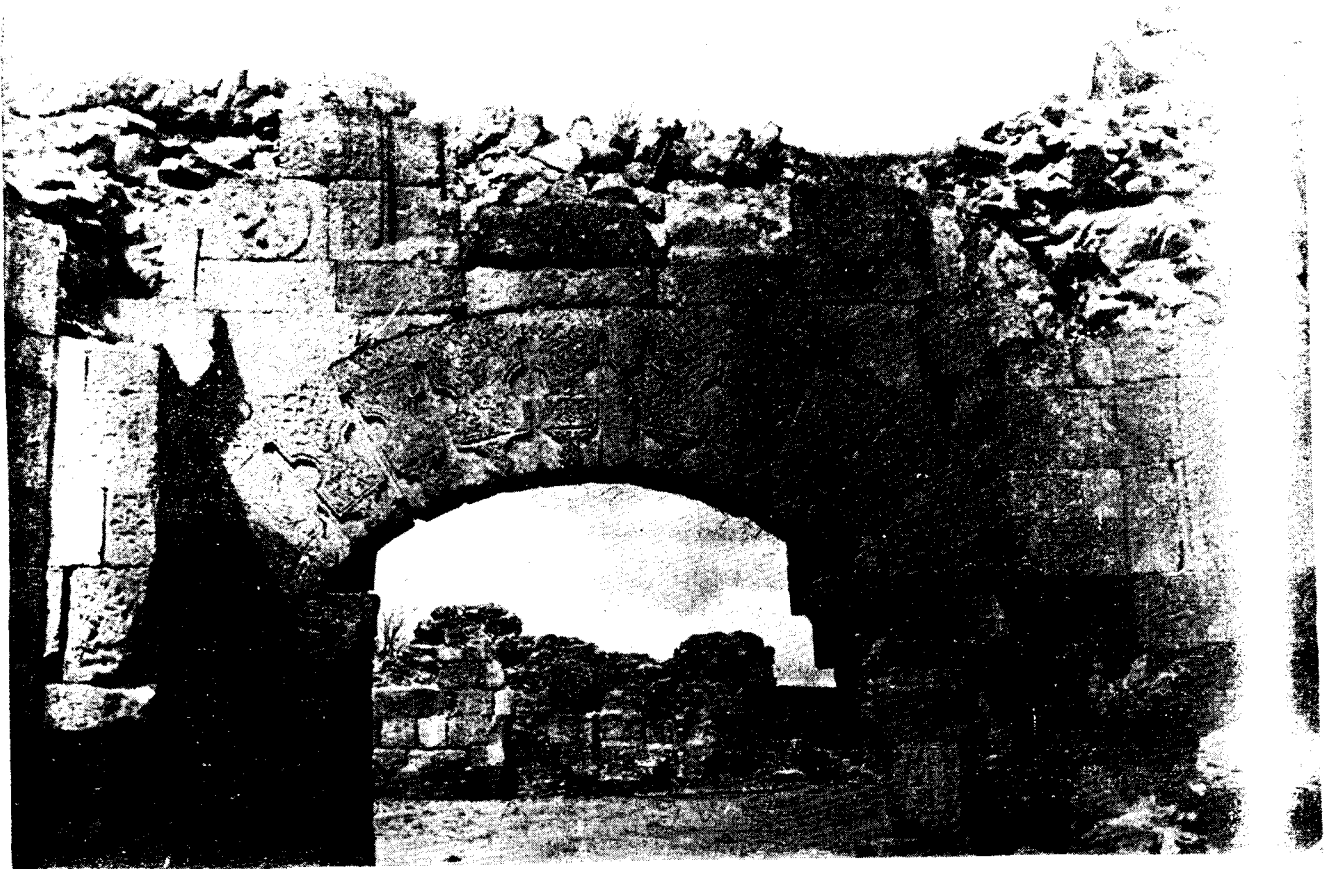
Resim : 21 — Caca Bey (Kesikköprü) Hanı - Kırşehir (Foto : Y. Önge)
