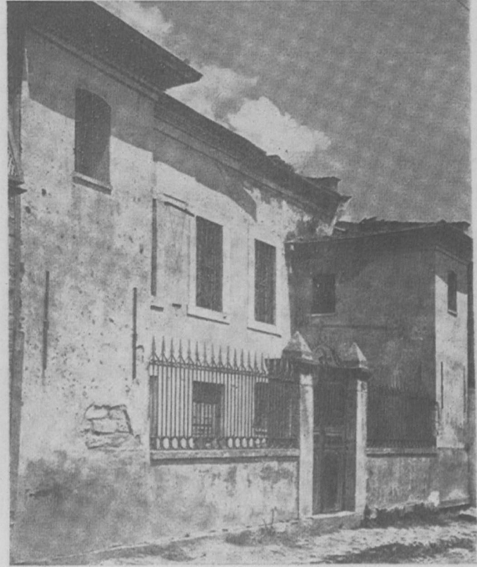
Res. 3 — Balâ Süleymanađa Camii kiblesindeki okul binası
