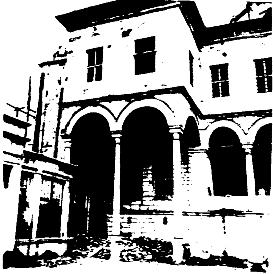
RESİM: 18 Beylerbeyi Camii kuzey cephesi - 1970
