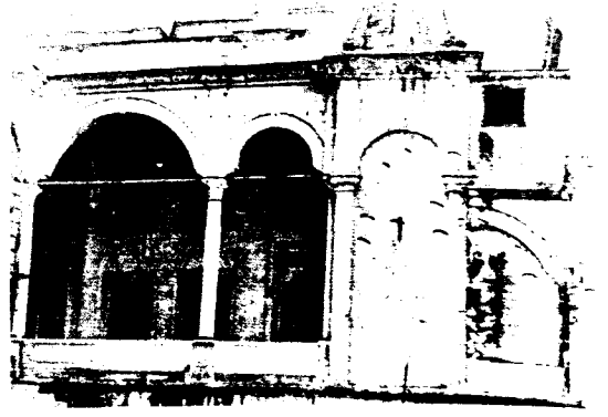
RESİM: 22 Selimiye Camii kuzey cephesi
