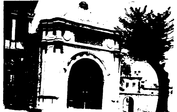
RESİM: 15 Laleli Camii Hünkâr Mahfili girişi - 1984
