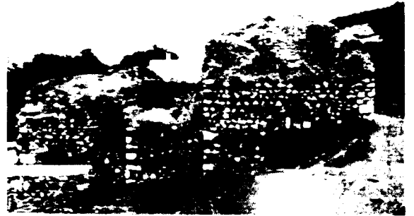
RESİM: 22 Hamamın dıştan görünüşü
