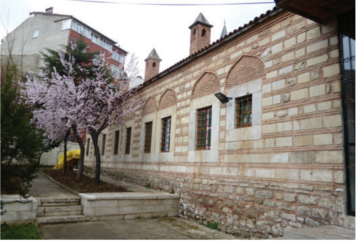
Resim 7: Mustafa Paşa Zâviyesi Güney Cephesi (2012)
