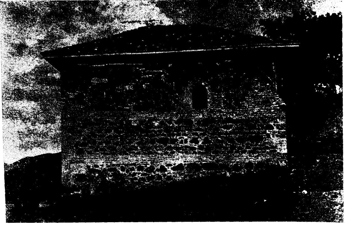
Res. 20 — Ali Baba Türbesi batı cephe (görünüş)
