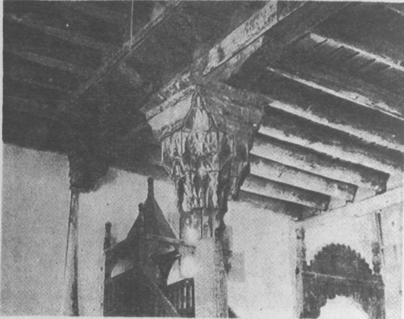
Resim: 7) Staláktitli sütun başlıkları ve tavan kirişlemesi (Onarımdan sonra)
