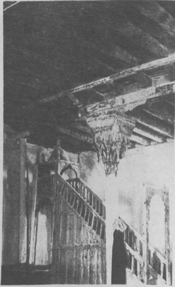
Resim: 6) Staláktitli sütun başlıkları ve tavan kirişlemesi (Onarımdan önce)
