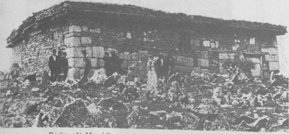
Resim: 4) Mescidin genel görünüşü (Onarımdan önce)
