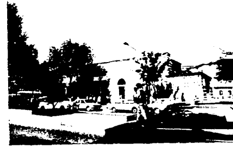
Üsküdar, Atik Valide Hamamı
